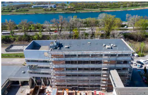
Lehrlingsausbildungszentrum Donaustadt - Umbau Foto (c) Wien Energie
